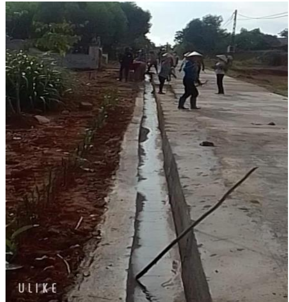
Hình 6: Đổ mương rãnh thoát nước tuyến làng mới và đắp bù lề
