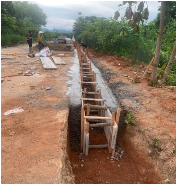
Hình 6: Đổ mương rãnh thoát nước tuyến làng mới và đắp bù lề
